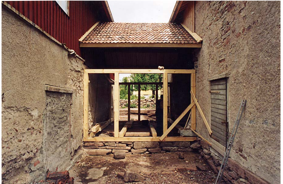
När taket var klart restes stommen till väggarna. På taket lades begagnat tvåkupigt tegel. Ny sockel av kallmurad kalksten. Juni 2004.
