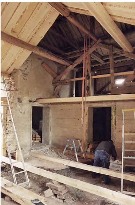
Samtidigt lades nya golvbjälkar. Juni 2004.
