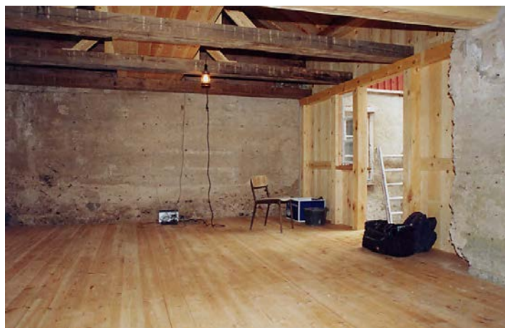
Det nya rummet sett mot väster. Aug. 2004.
