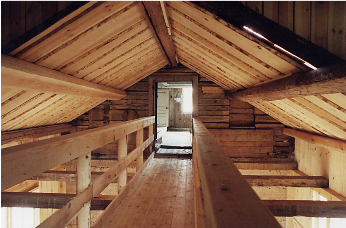
De båda övervåningarna sammanbinds med en gångbro, för övrigt lämnades bjälklaget utan golv. Blick mot väster in i bostadens förstuga. Aug. 2004.
